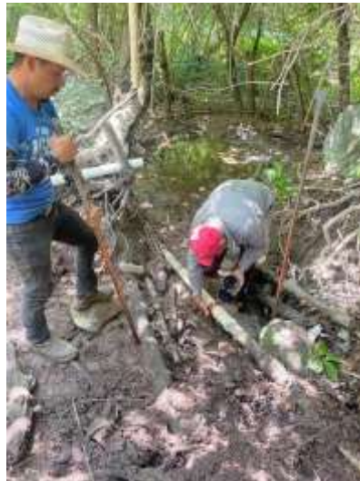
Tenencia El Rodeo, destapando tubo de agua de la línea de conducción.
