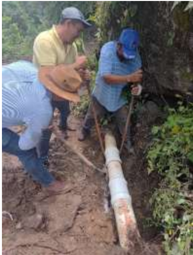
Línea de conducción, reparación del tubo.
