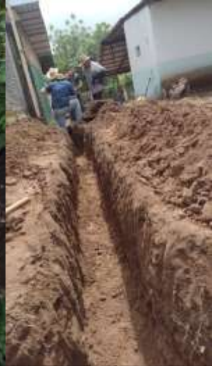
Tenencia El Charapo, zanja para poner drenaje.
