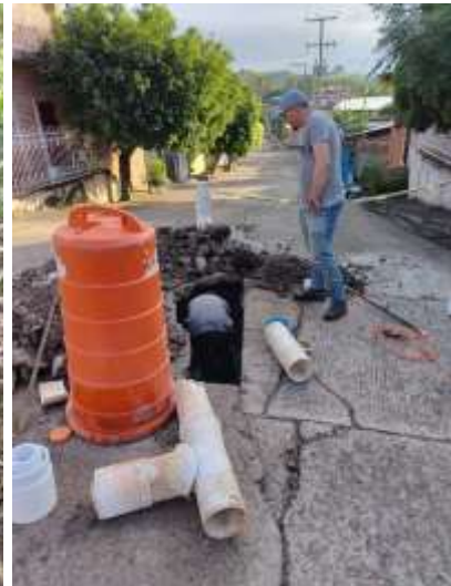
Calle Hilario Reyes, reparación del tubo principal del agua.
