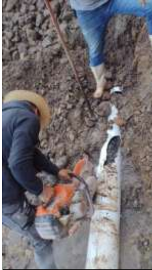
Línea de conducción La Alberca a Aguililla, reparación del tubo de conducción.
