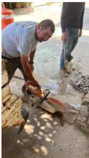
Calle Francisco Villa, haciendo corte para buscar tubo de agua.
