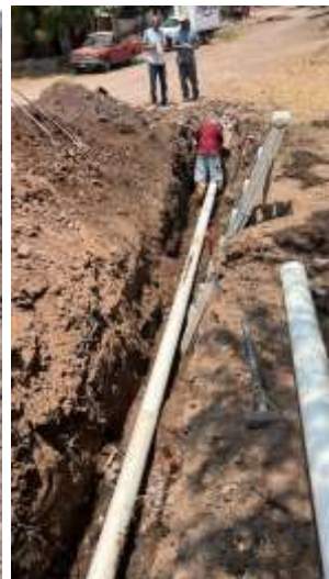
Tenencia El Limón, Reparación de tubo de drenaje.
