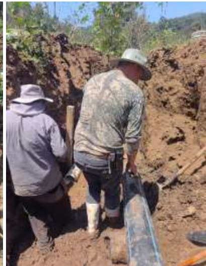
Línea de conducción manantial La Alberca, reparación y cambio de tubo.
