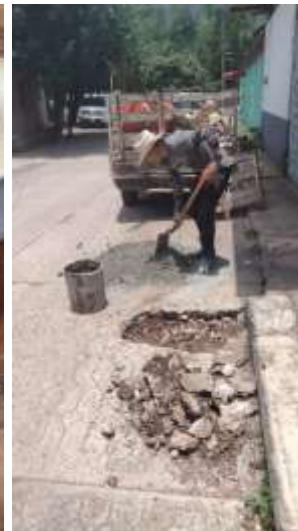
Calle Niños Héroes y Salida a Dos Aguas, reparación de baches.
