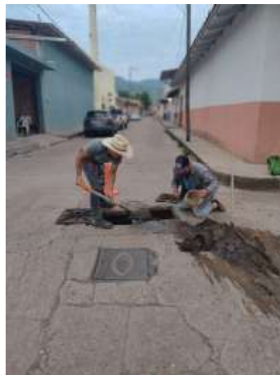
Calle Matamoros esquina con Benjamín Ruiz, desazolve de válvulas para buscar tapón.
