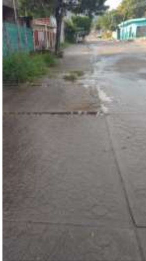
Calle Progreso colonia Cantera, fuga de agua del tubo principal.
