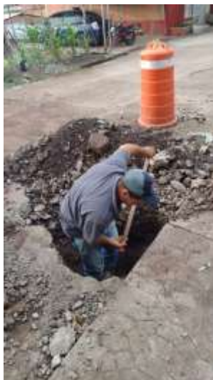
Calle Matamoros, buscando fuga de agua para reparar.
