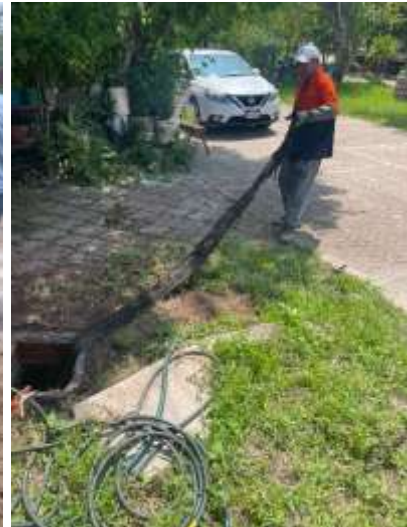
Tenencia El Limón, desazolve de tubo de drenaje principal.
