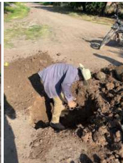
Naranjo de Chila, buscando tubería de drenaje principal para reparar.
