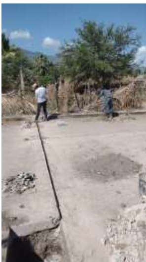
Haciendo nueva instalación de toma de agua.
