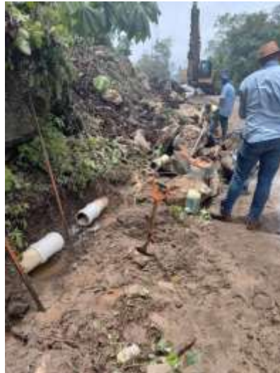
Línea de conducción, reparación del tubo.
