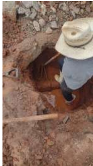
Calle Abasolo y Sánchez Tapia, reparación de fuga de agua del tubo principal.
