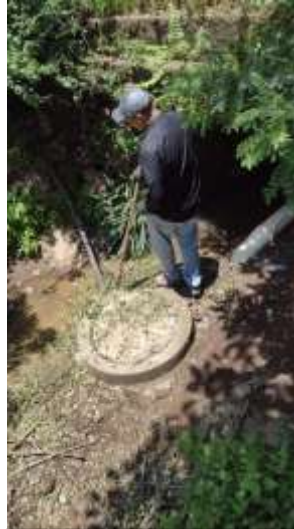
Revisando registro de drenaje principal.
