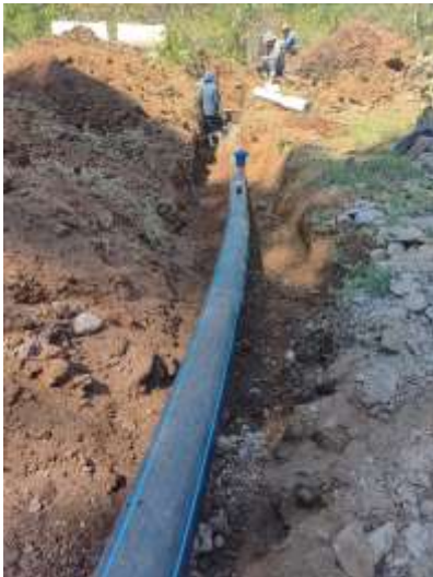
Línea de conducción manantial La Alberca, cambio de tubo.
