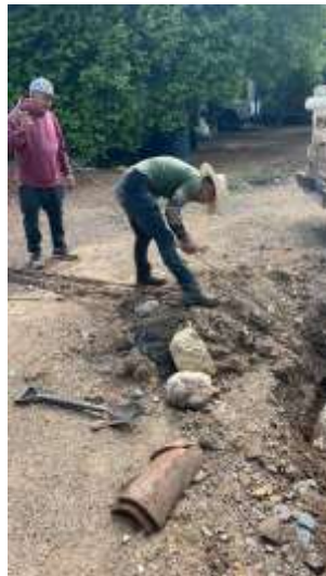
Naranjo de Chila, reparación de drenaje principal.
