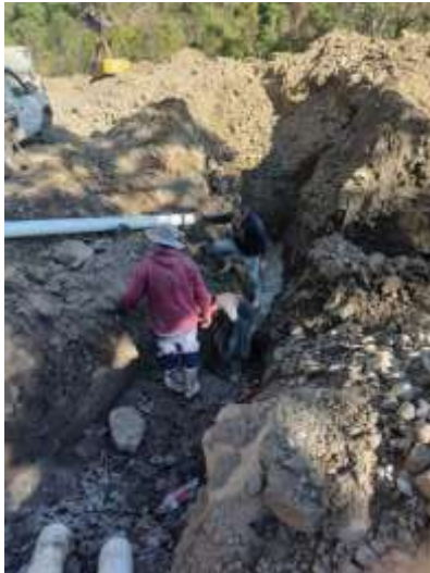
Línea de conducción manantial La Alberca, reparación y cambio de tubo.
