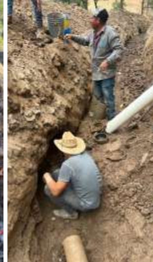
Línea de conducción manantial La Alberca, reparación y cambio de
