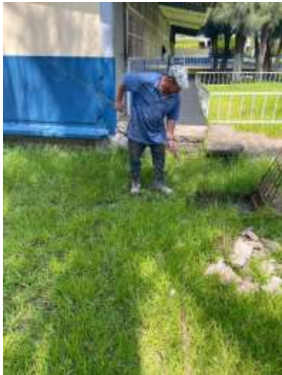
Escuela Sec. Tec. No. 21, desazolve de drenaje.
