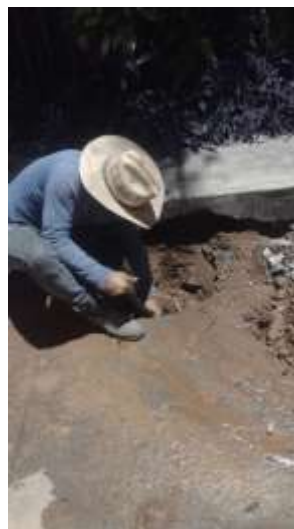
Calle Progreso, reparando tiradero de agua.
