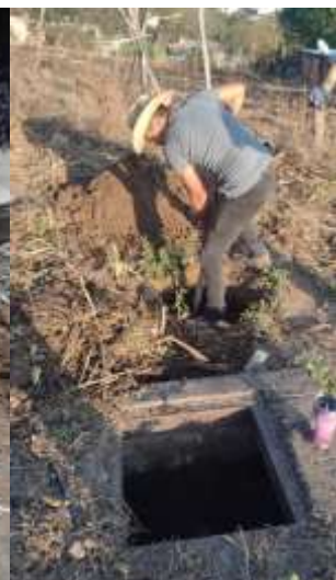
Reparando válvula.
