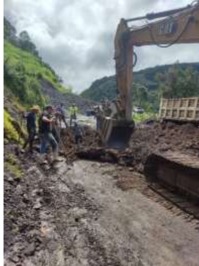
Línea de conducción La Alberca a Aguililla, reparación del tubo de conducción.
